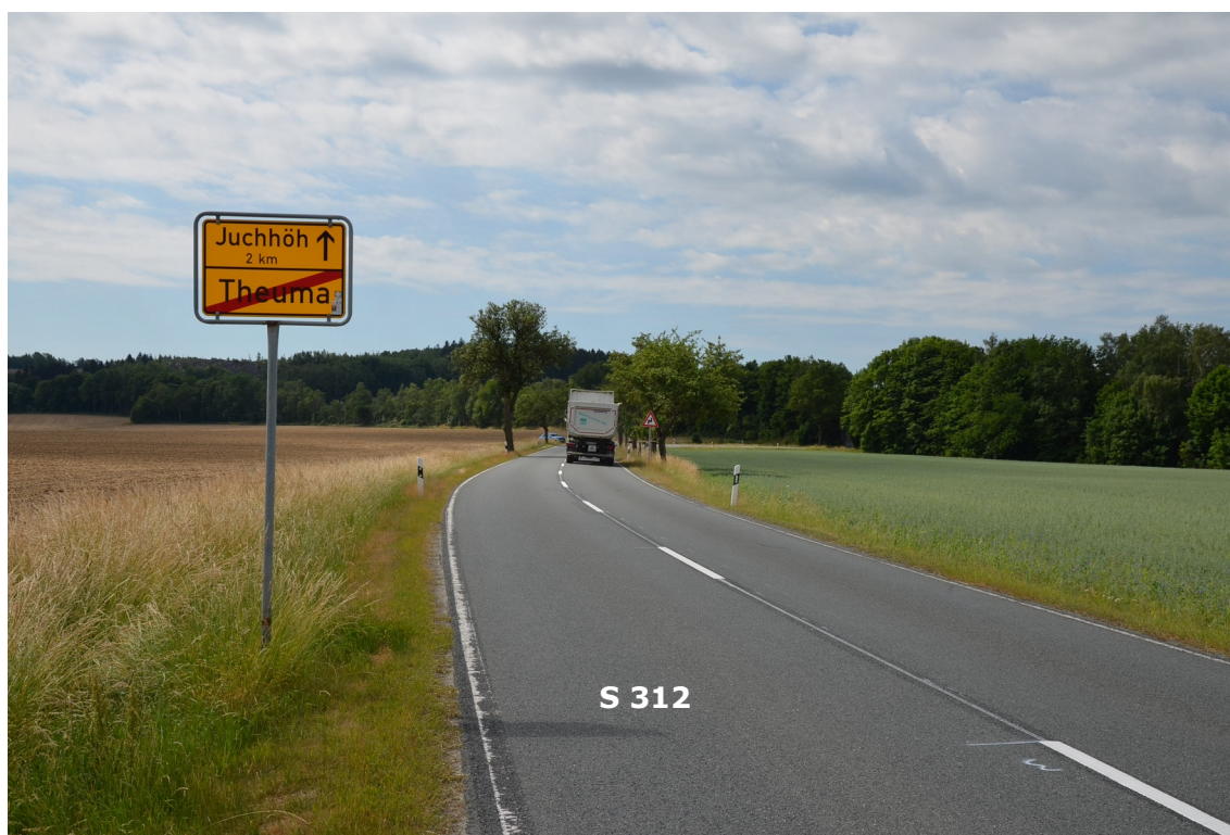
Bild 8: Blick in südliche Richtung zum Ortsausgang
