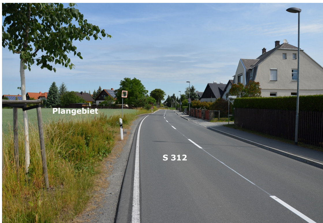
Bild 2: Blick in nördliche Richtung entlang der Oelsnitzer Straße (S 312); das Plangebiet befindet sich links
